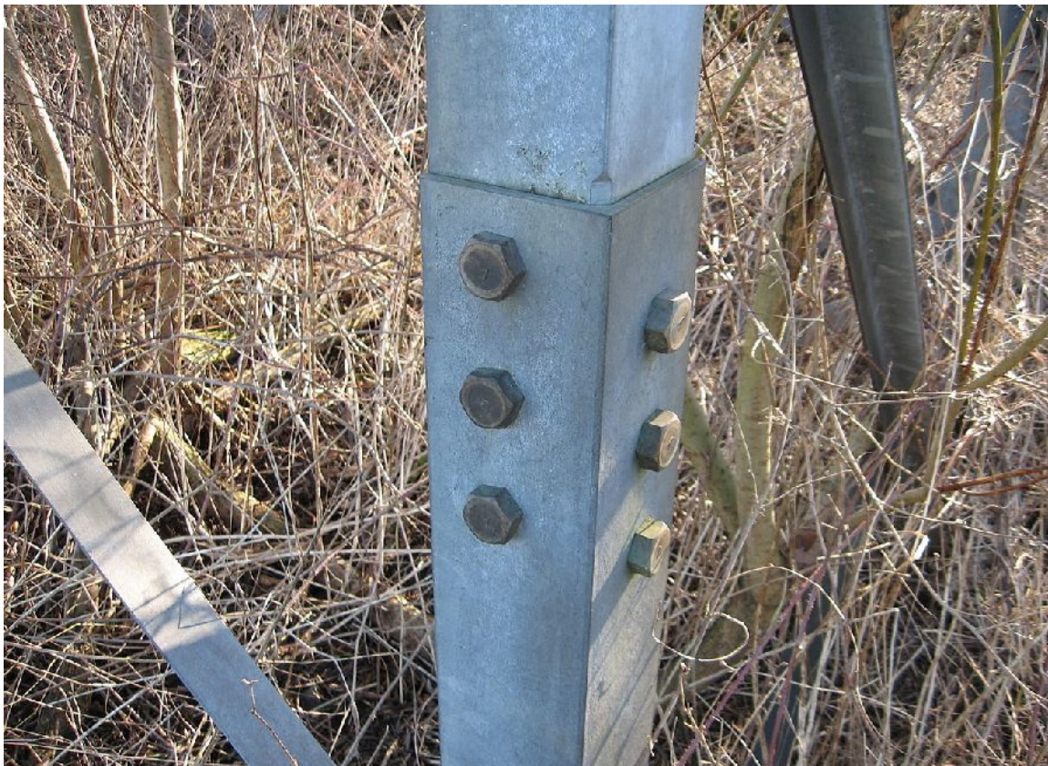
W-5. Konstrukcje cienkościenne - połączenia
